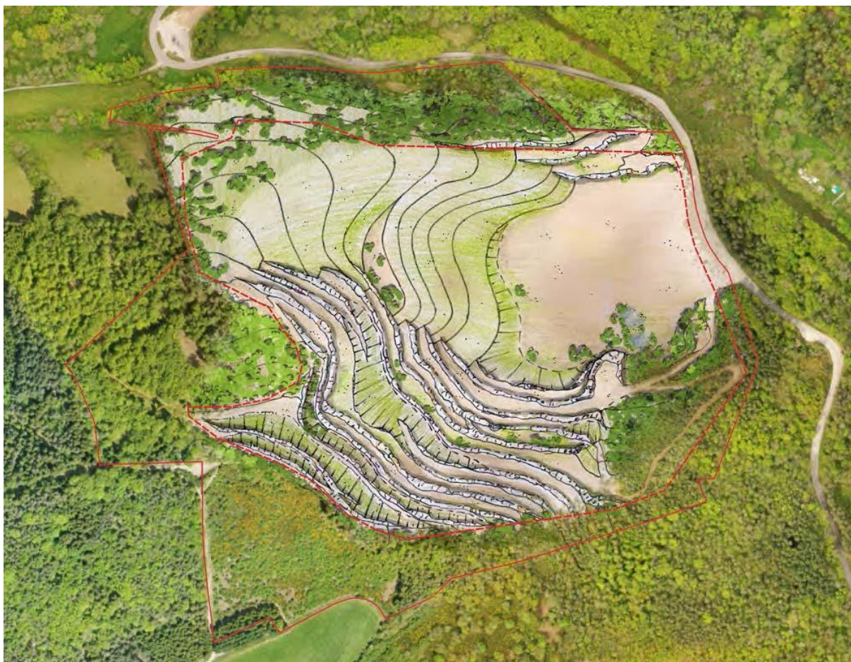
Insertion paysagère de la carrière après réaménagement
